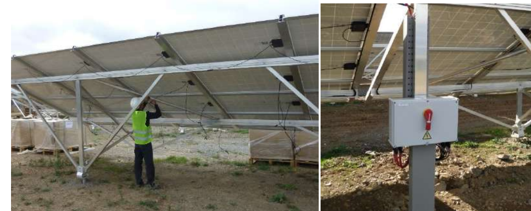
Figure 85 : A gauche : Câblage des panneaux – A droite : Boîtier de raccordement - QENERGY
