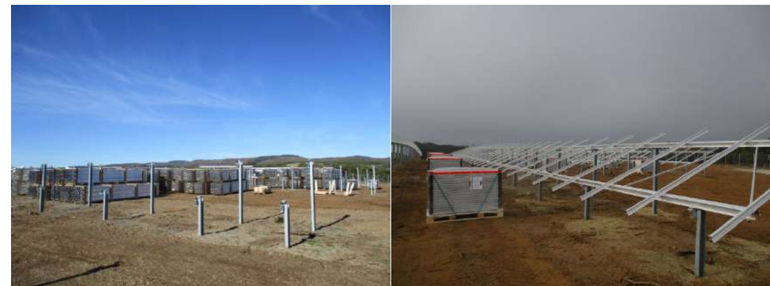
Figure 81 : Assemblage des structures sur site – QENERGY
