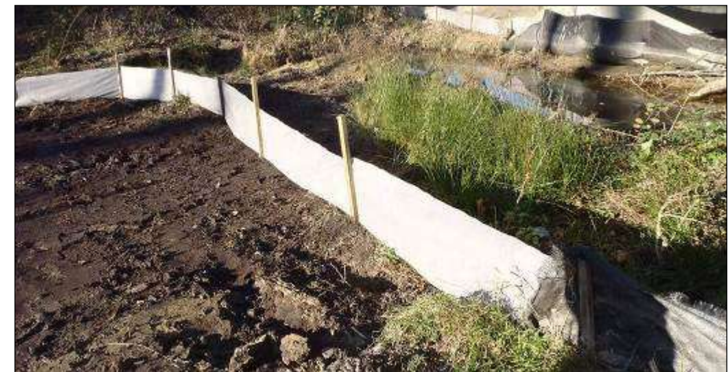
Figure 115 : Implantation de barrières amphibien en géotextile permettant d'éviter les déplacements des individus du cours d'eau vers le chantier © ETEN Environnement
