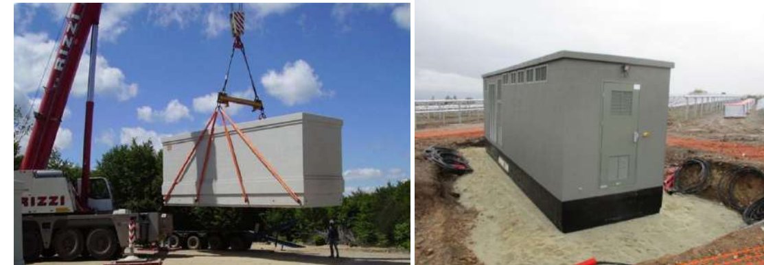
Figure 84 : Installation d'un poste électrique - QENERGY
