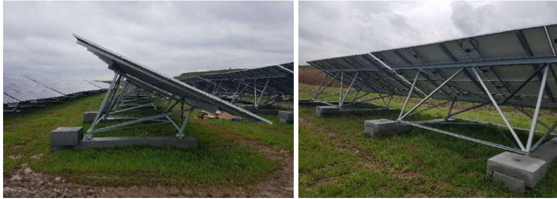
Figure 70 : Exemple de fondations béton - QENERGY
