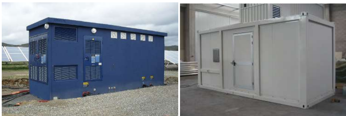
Figure 71 : Exemples d'onduleurs et transformateur installés dans des postes béton et containers
