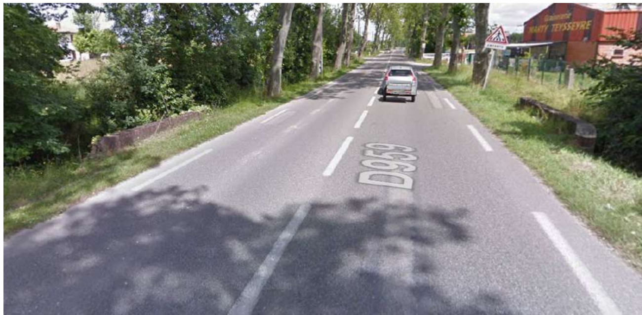
Figure 129: Passage busé permettant le franchissement du cours d'eau Le Petit Mortarieu par la route D959. Source : Street view - Google Maps
