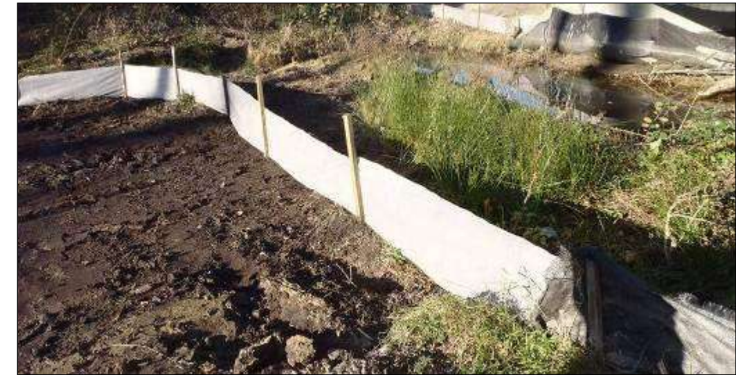
Figure 33 : Implantation de barrières amphibies en géotextile permettant d'éviter les déplacements des individus du cours d'eau vers le chantier © ETEN Environnement
