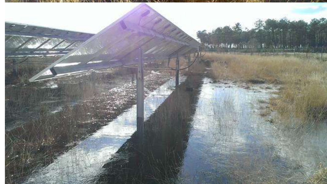
Figure 21 : Zone humide préservée dans une centrale photovoltaïque des Landes de Gascogne © ETEN environnement
