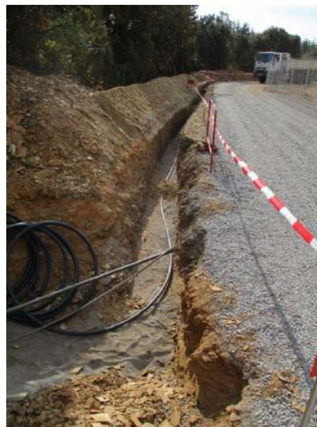
Figure 83 : Exemple de tranchée en bordure de piste – QENERGY
